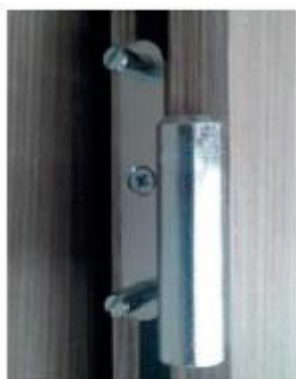
DETAIL TRNŮ PROTI VYSAZENÍ
